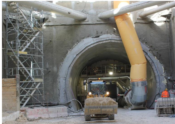
Figure 3 : Chantier du Prolongement de la ligne 4. (Sources : Bégué Arnaud)
