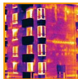
Vue d'un immeuble à la caméra infrarouge
