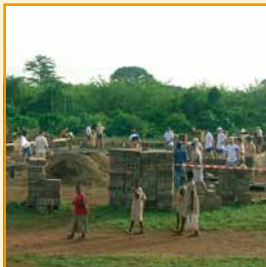
Nounya Etxea en construction
