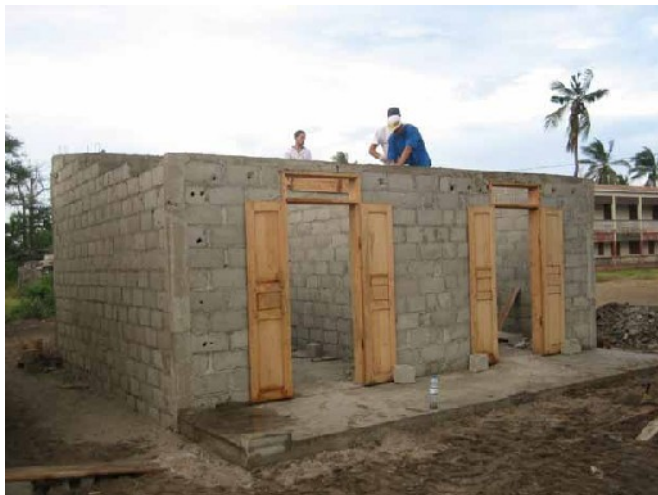
Bâtiment bibliothèque - bureau du directeur
