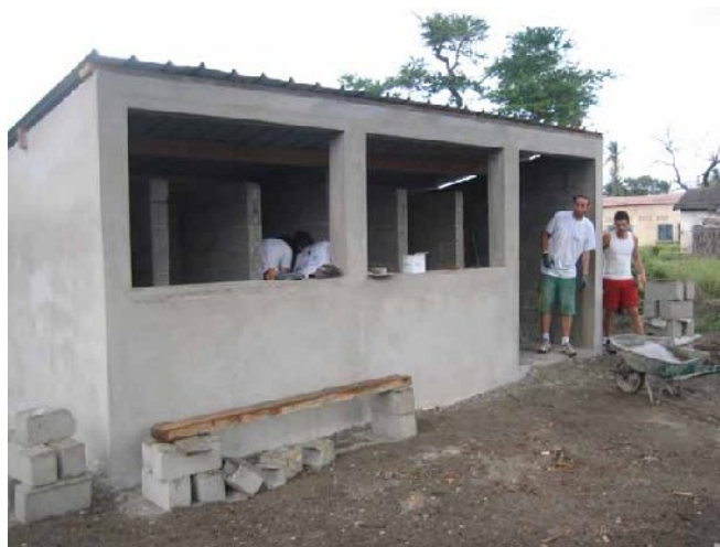
Les toilettes enduites
