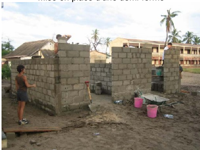
Bâtiment bibliothèque - bureau du directeur
