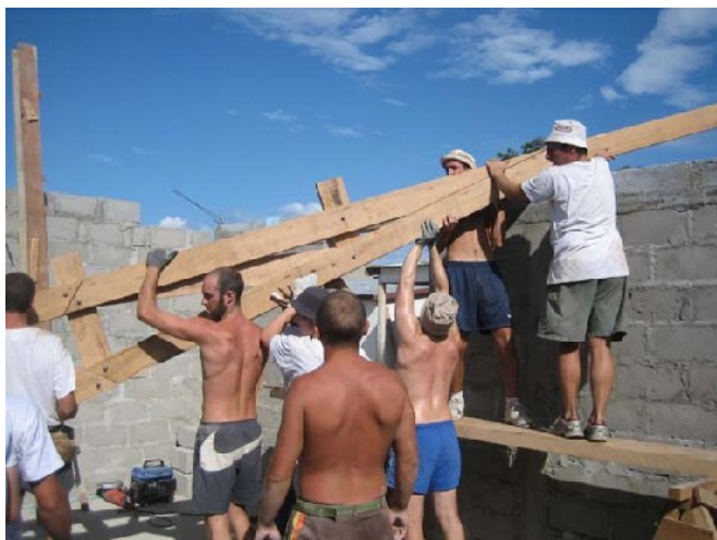
Mise en place d'une demi-ferme
